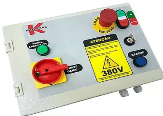
Figura 8 – sistema de partida e parada com botoeira de emergência e reset .
