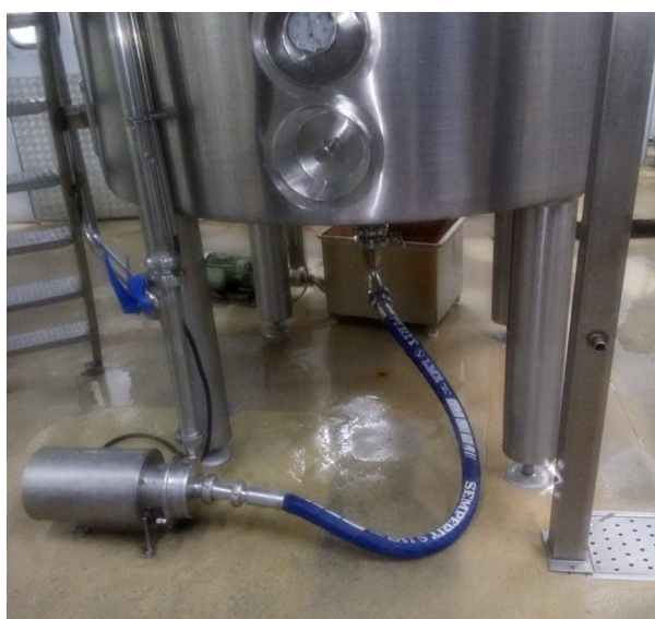
Figura 7: Sistema CIP dos maturadores.
