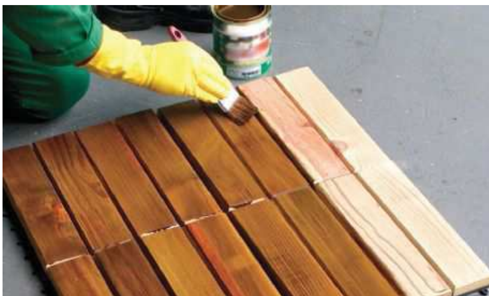
Figura 18 - acabamento com pintura Stein Fonte: Elaborado pelo autor (2017)
