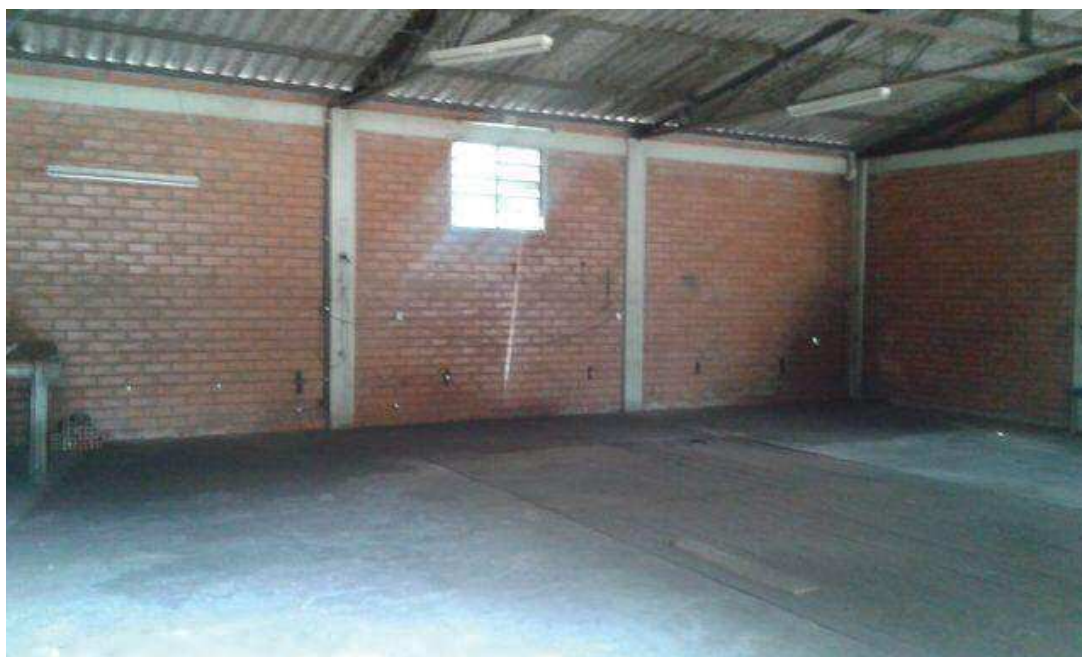
Figura 10 - interior do galpão Fonte: Elaborado pelo autor (2017)
