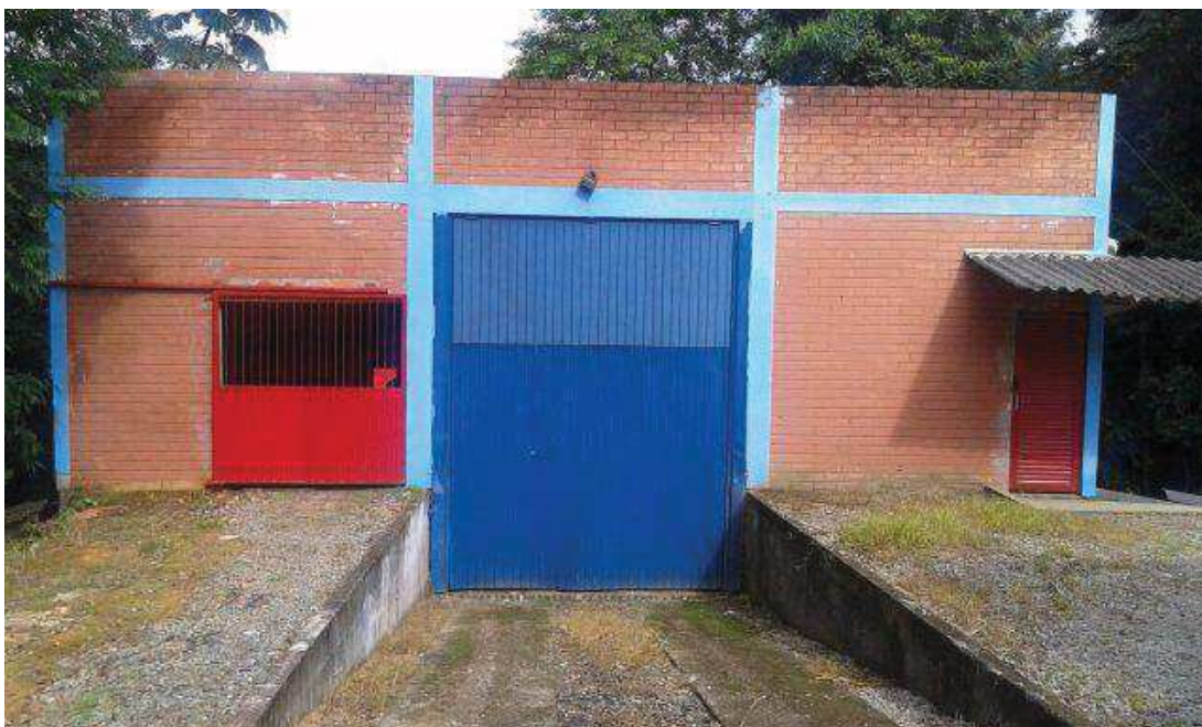
Figura 9 - fachada do galpão Fonte: Elaborado pelo autor (2017)
