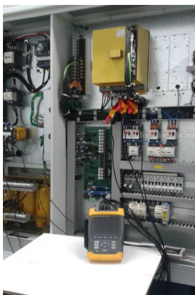
FIGURA 27 – Equipamento utilizado para medição da corrente
