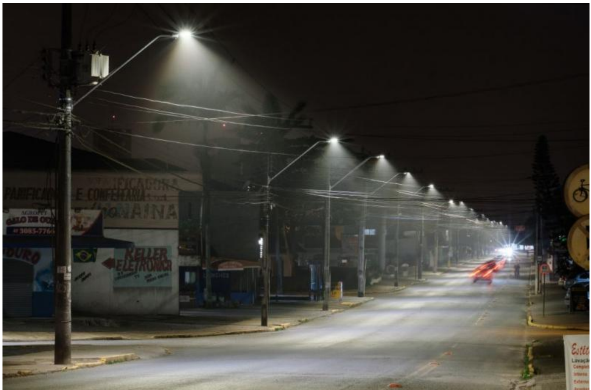
Figura 16 – Rua Prefeito Baltazar Buschle, bairro Comasa com LED.
