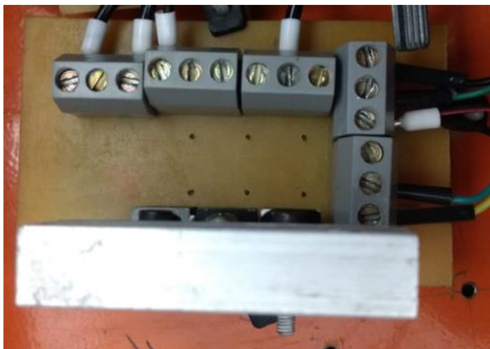
Figura 12 – Placa de potência em funcionamento
