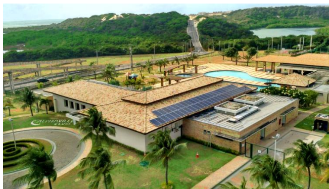
Figura 2 - Microrrede do condomínio Alphaville Fortaleza.
