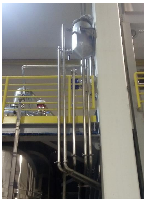
Figura 2.4 – Tubulações de aço inoxidável AISI 304L em uma indústria de alimentos
