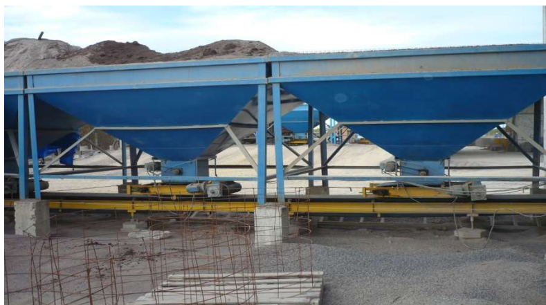
FIGURA 11 - Silo de agregados
