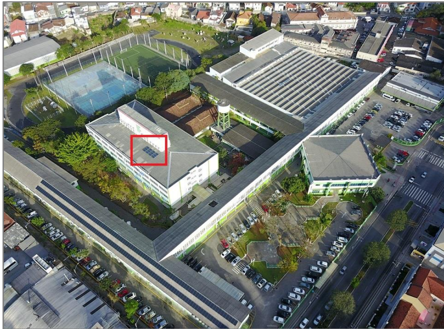
Figura 10 – Fotografia aérea do SFCR de 3,060 kWp do Câmpus IFSC Florianópolis-Centro
