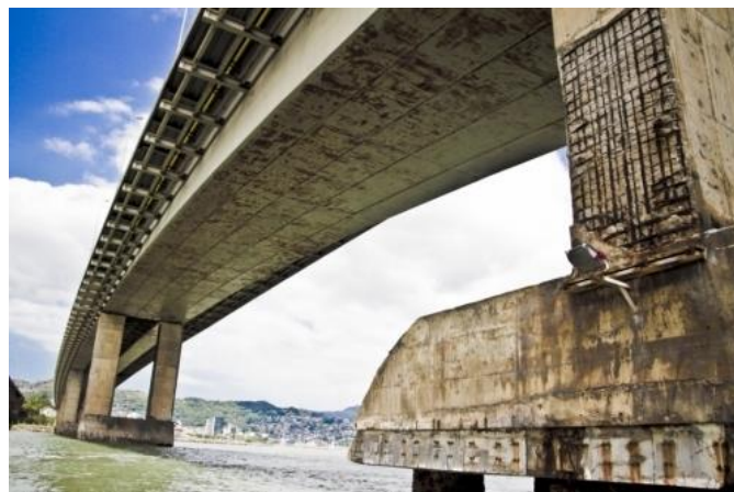
Figura 10 – Ponte Pedro Ivo.
