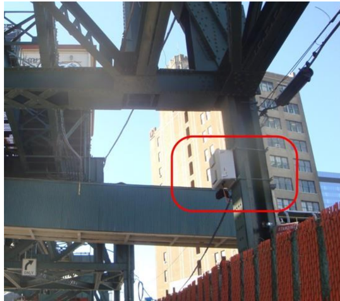
Figura 16 – Monitoramento remoto de viaduto em Long Island.
