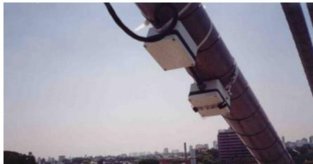
Figura 13 – Acelerômetro na ponte Octávio Frias de Oliveira.
