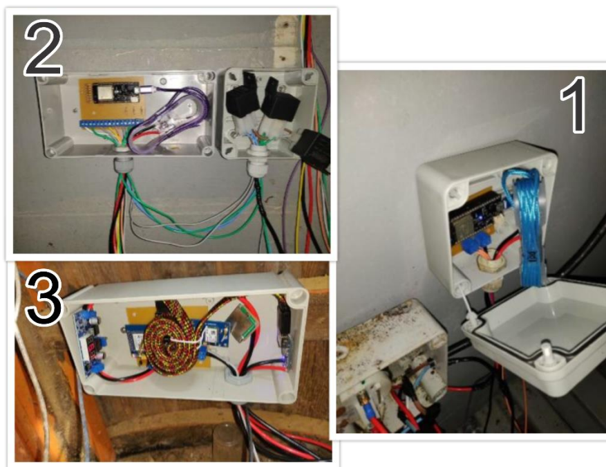
Figura 30 - Gabinetes dos módulos instalados - (1) PCI da Cozinha, (2) PCI da casa de máquina, (3) PCI do comando
