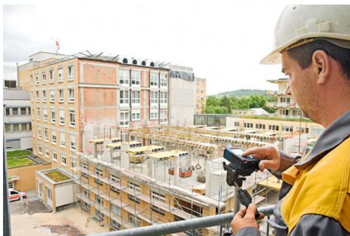
Figura 2- Aplicação trena a laser construção civil
