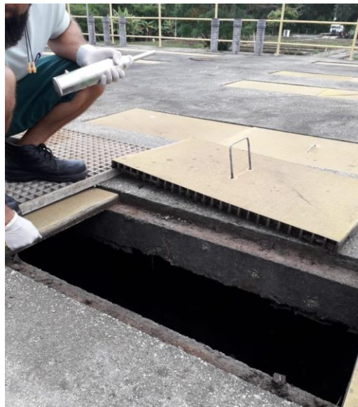
Figura 36 - Marcação dos pontos na tampa superior do reator 3
