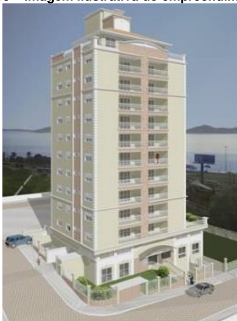
Figura 10 – Imagem ilustrativa do empreendimento “B”
