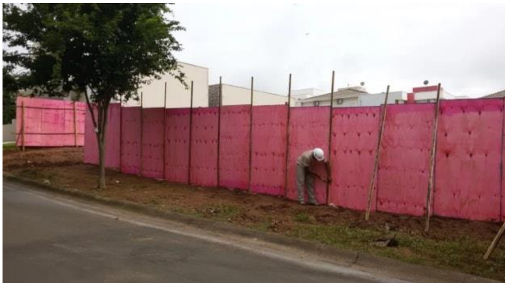
Figura 8 – Tapume de madeira.
