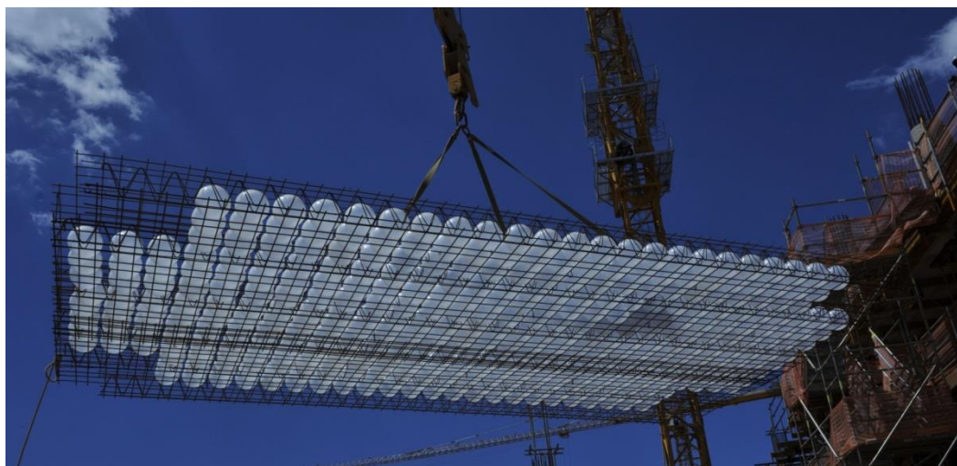
Figura 2 – Módulos BubbleDeck
