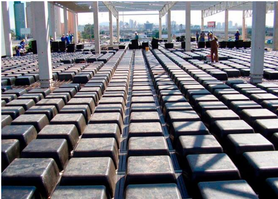
Figura 5 – Formas plásticas antes da concretagem.
