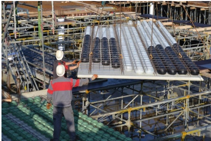
Figura 3 – Posicionamento da pré-laje.
