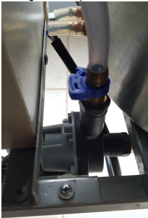
Figura 13 - Fixação da bomba
