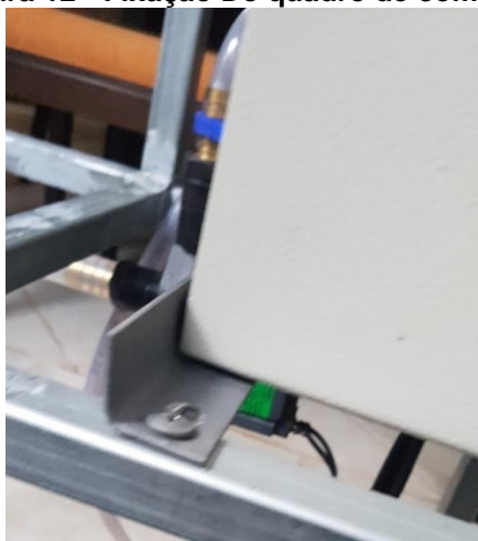
Figura 12 - Fixação Do quadro de comando
