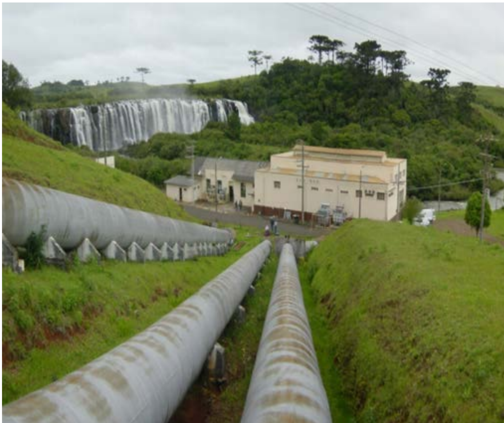
Figura 54 - Usina Caveiras e conduto forçado
