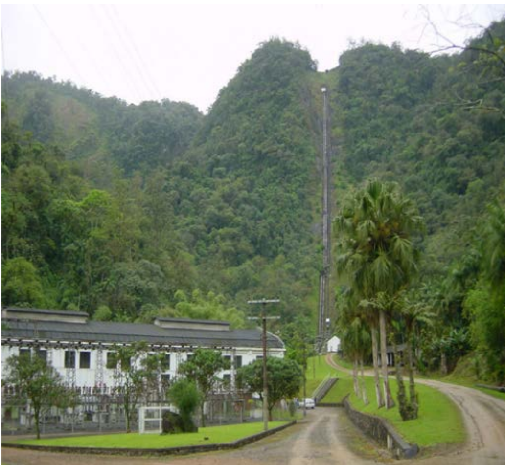
Figura 53 - Usina Bracinho e conduto forçado
