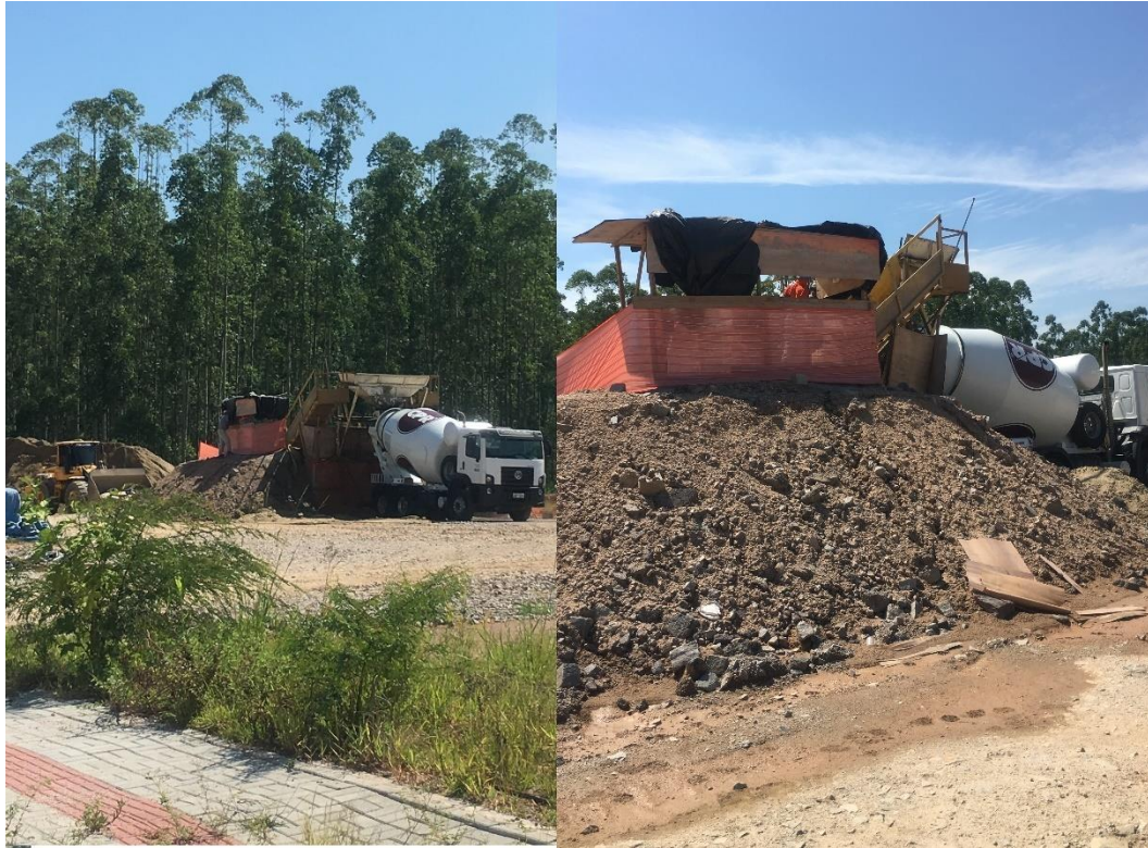
Figura 38 e 39 – Preparo do geogROUT
