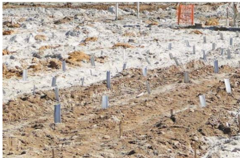
Figura 36 - Geodrenos instalados no terreno
