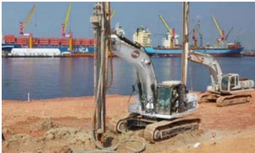
Figura 41 - Execução das verticais
