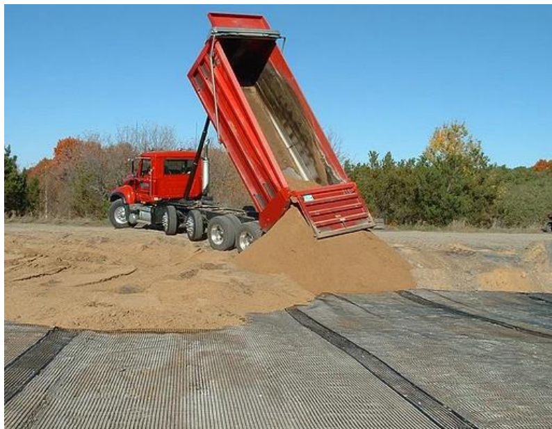
Figura 31 - Aterro de ponta com geogrelhas
