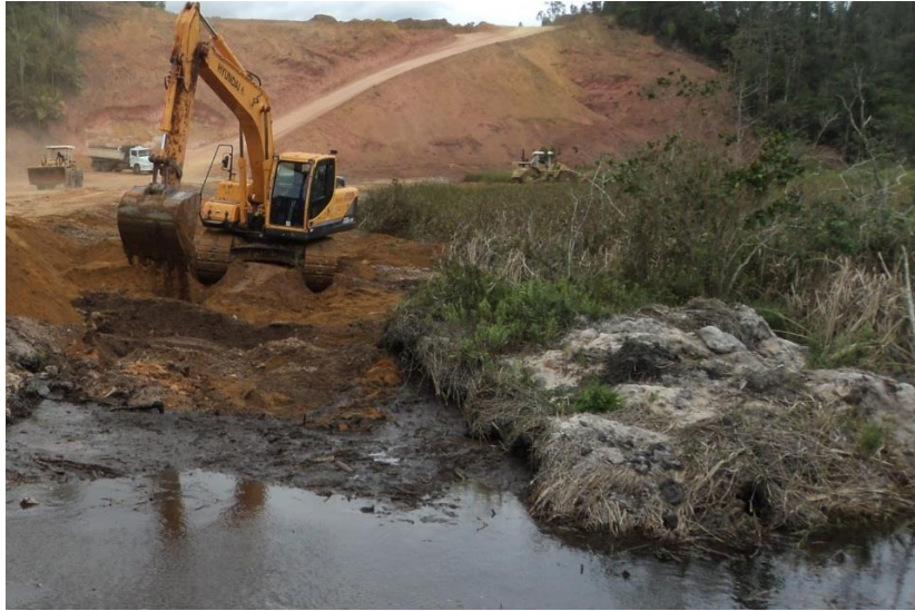
Figura 35 - Equipamento realizando trabalho sobre aterro de conquista
