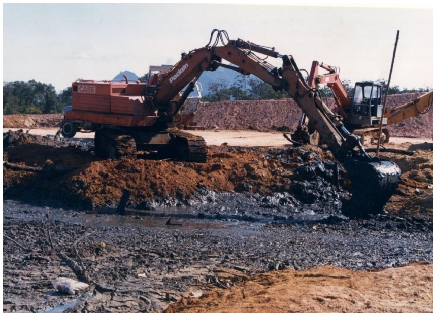
Figura 30 - Retirada de solo mole para futuro aterro
