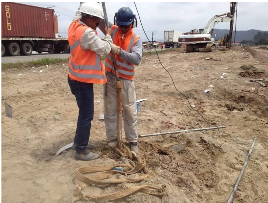
Figura 37 - Instalação do piezocone
