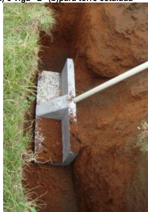
Figura 4 – Instalação de sapata pré-moldada (a) e viga “L” (b) para torre estaiada
