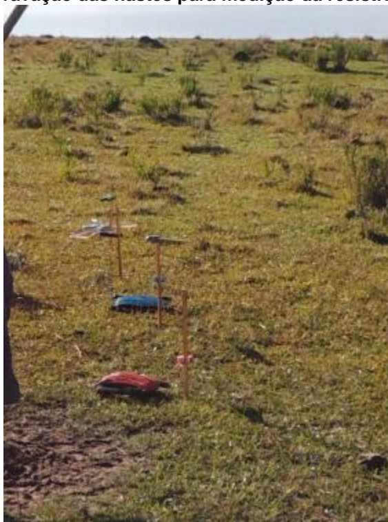
Figura 18 – Cravação das hastes para medição da resistividade do solo
