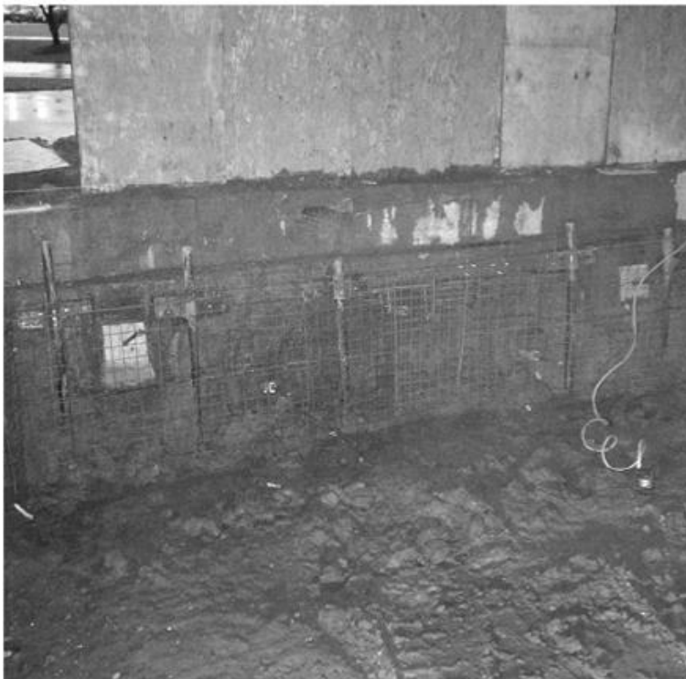
Figura 9 – Muro de contenção após estabilização por uso de estaca helicoidal
