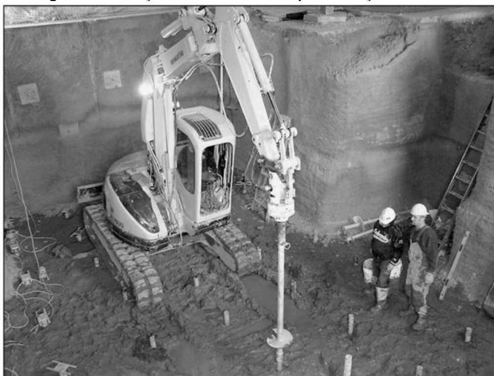
Figura 7 – Instalação de estaca helicoidal para fundação subterrânea
