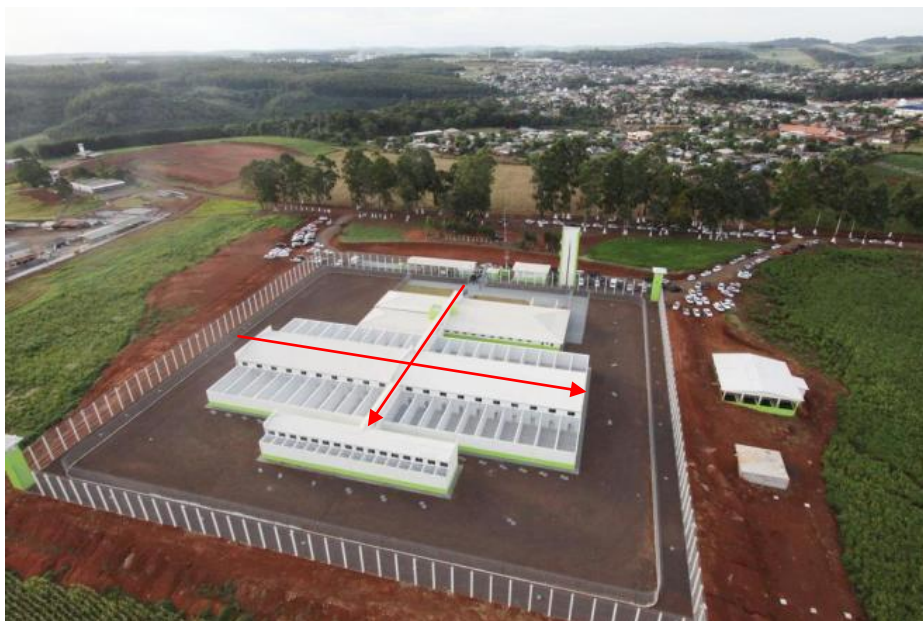
Figura 14 - Presídio regional de Chapecó, exemplo de unidade penal com padrão arquitetônico paralelo. Em destaque, os corredores do pavimento superior
