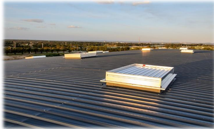
Figura 28 - Clarabóias para a extração de fumaça
