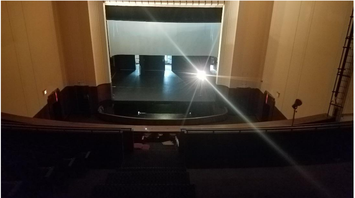
Figura 5 – Palco do auditório da Manhattan School of Music antes da reforma
