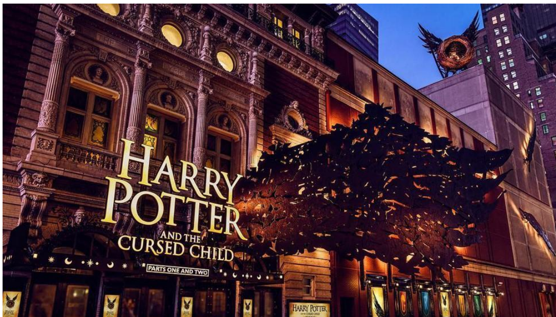
Figura 12 – Fachada do The Lyric Theater, na Broadway, após reforma gerenciada pela Yorke Construction Corporation para a peça Harry Potter and the Cursed Child
