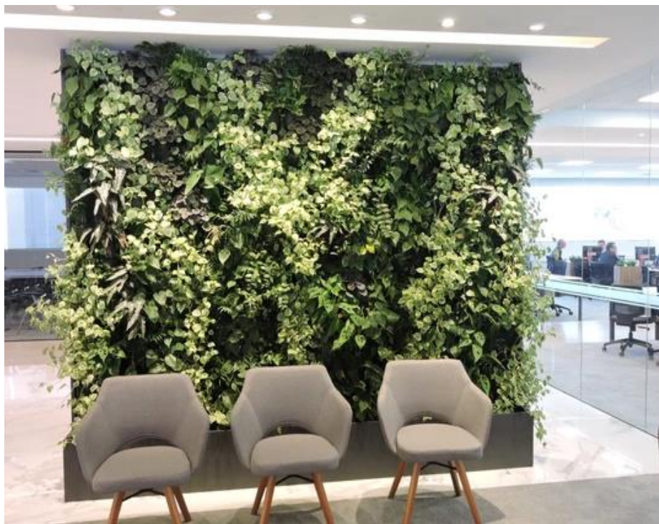
Figura 15 - Parede viva com sistema de painéis geotêxteis modulares.
