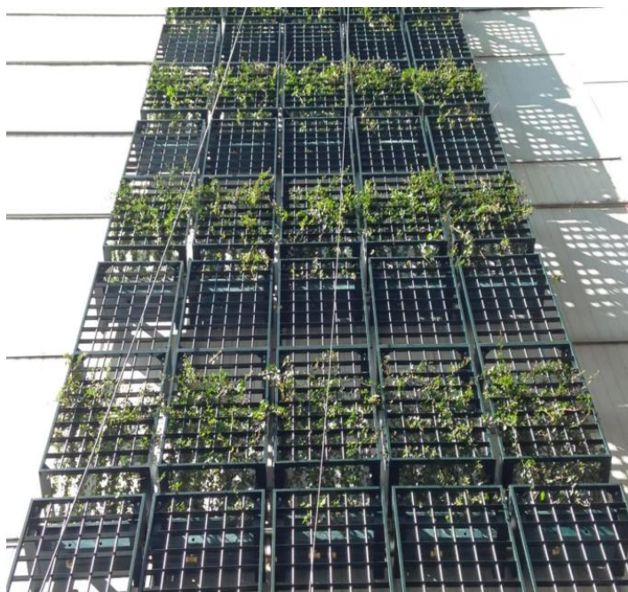
Figura 14 - Fachada Verde com suporte de treliças instalada em Vancouver.
