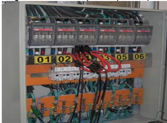
Figura 10 – Quadro de força com as pontas de prova
