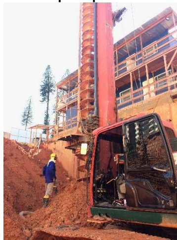
Figura 05 – Máquina perfurando o terreno
