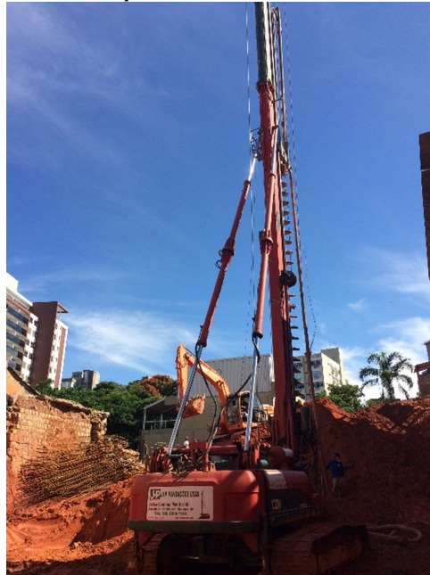
Figura 03 - Máquina Perfuratriz Hélice Contínua
