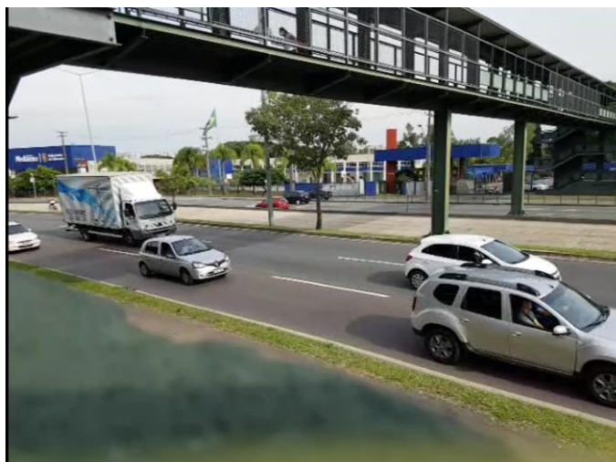
Figura 60 - Veículos passando sob a passarela
