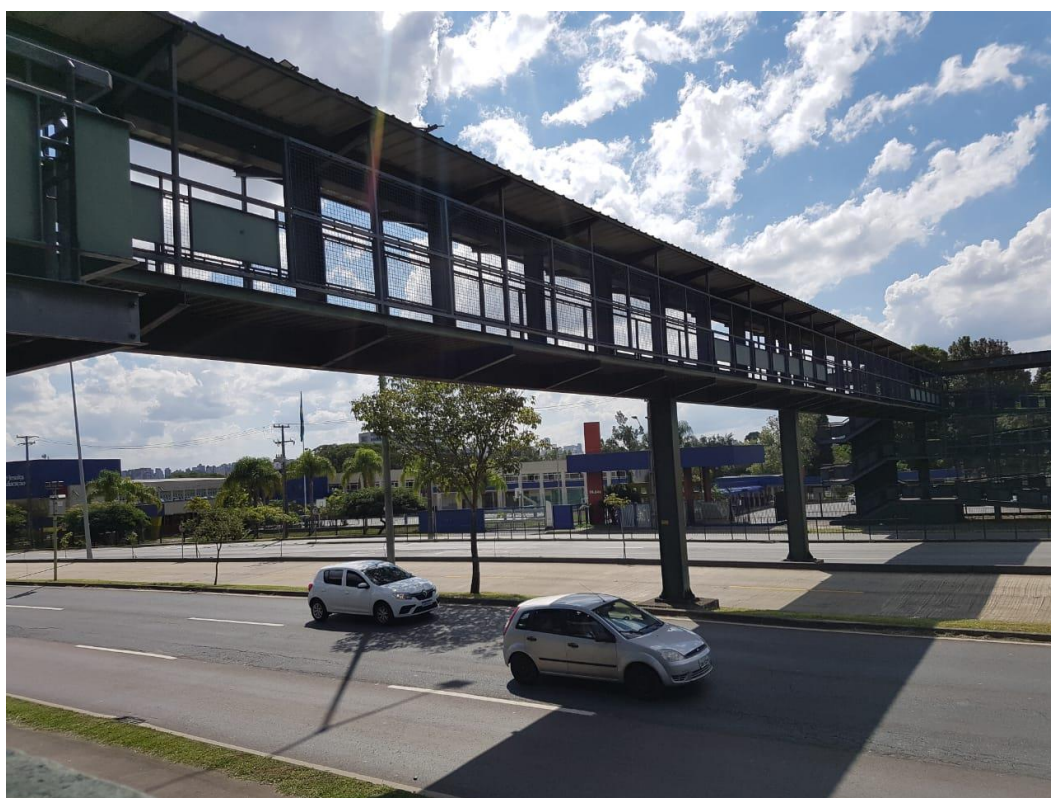
Figura 56 - Passarela sobre Linha Verde
