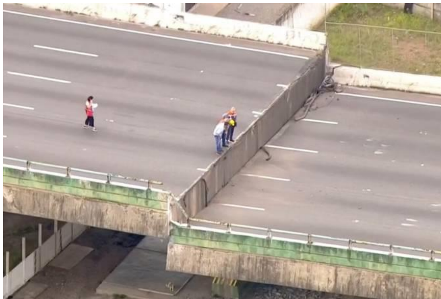
Figura 1 - Acomodação de ponte na Marginal Pinheiro em São Paulo
