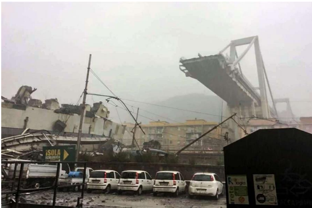
Figura 2 - Queda de ponte em Gênova
