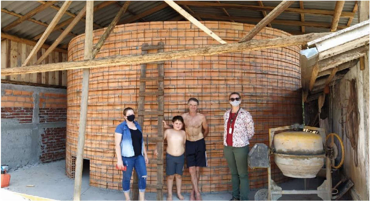
FIGURA 8 – Visita a um silo secador em construção.
