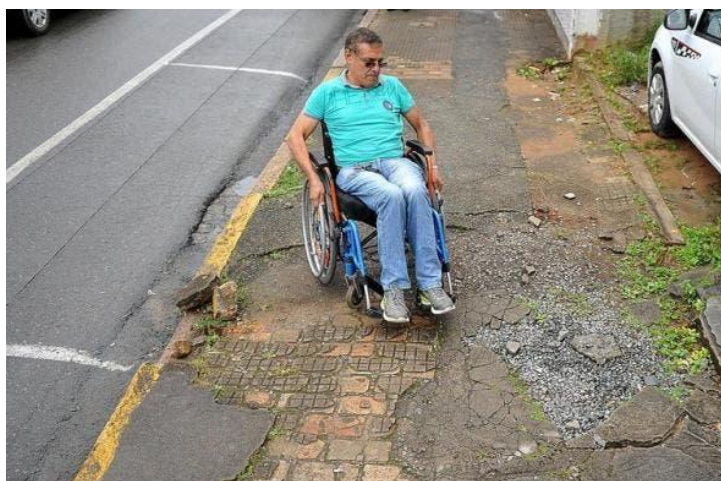
Figura 1 – Limitação de acessibilidade em calçadas.
