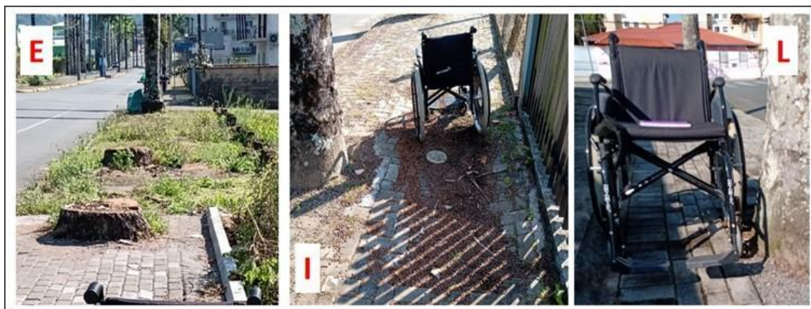
Figura 31 – Rota 2: Trecho 4 pontos E, I e L, criticidade 2.
