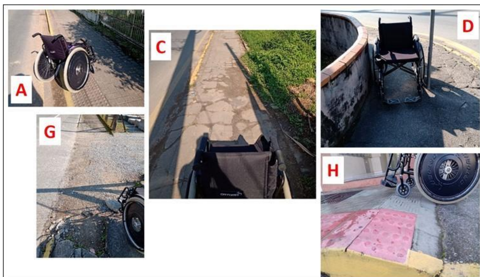
Figura 25 – Rota 2: Trecho 3 pontos A, C, D, G e H, criticidade 1.
