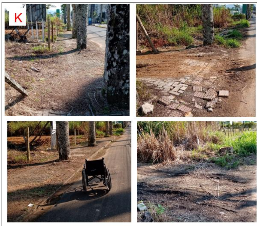
Figura 40 – Rota 3: Trecho K, criticidade 3.
