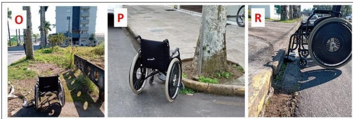
Figura 33 – Rota 2: Trecho 4 pontos O, P e R, criticidade 3.
