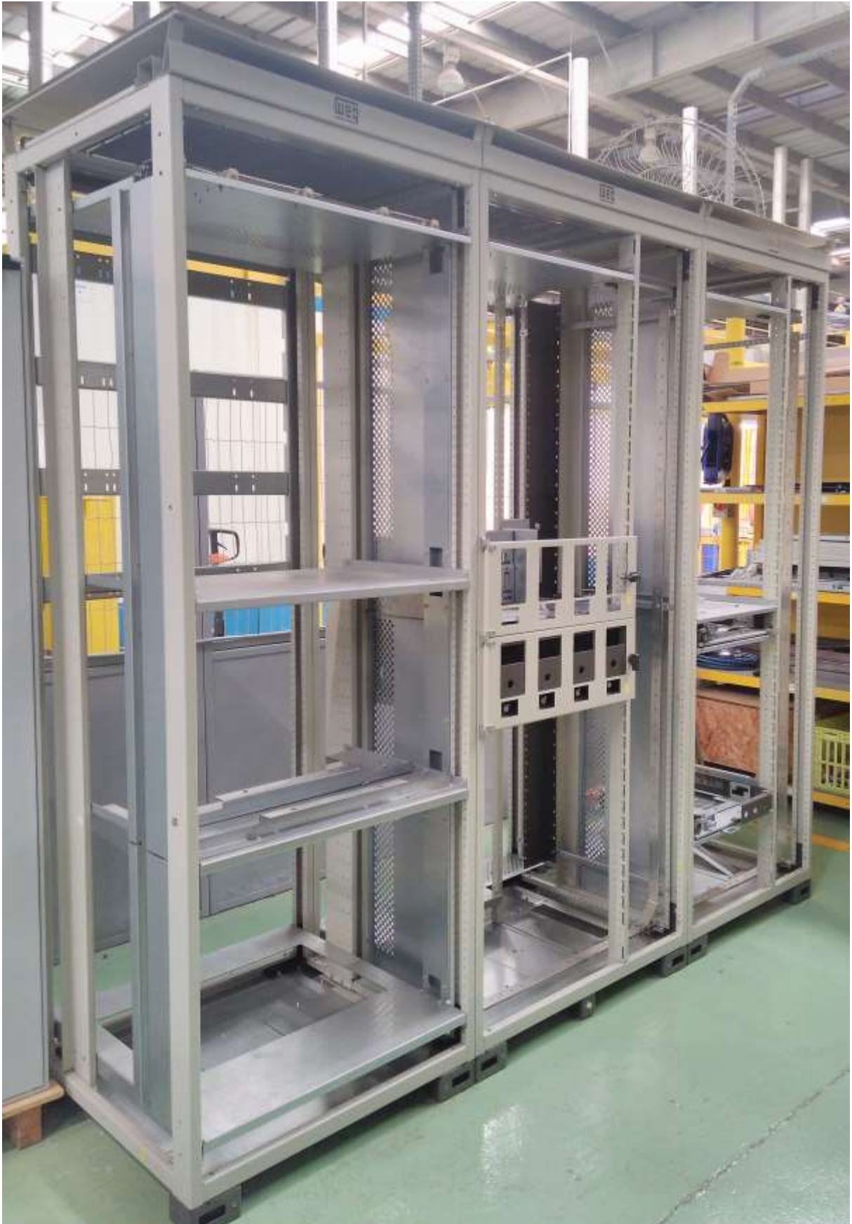
Figura 19 – Protótipo do QGBT completo
