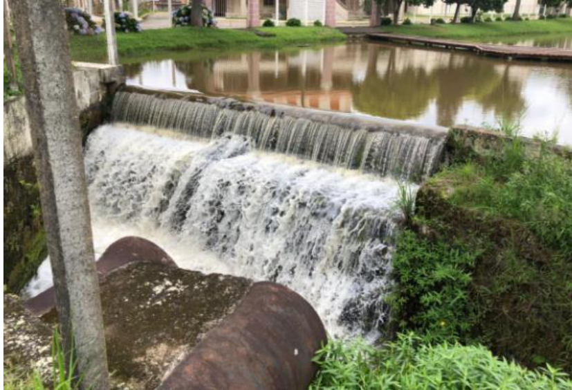
Figura 24 - Barragem a montante do local de instalação
