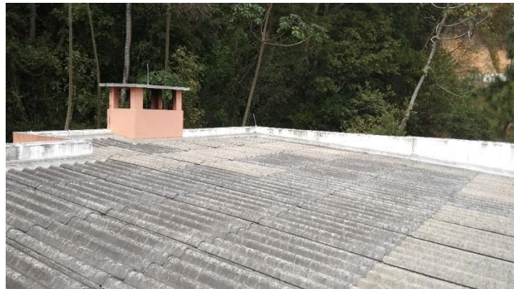
Figura 13 - Vista do talude a partir da cobertura do apartamento 302
