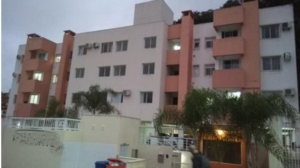
Figura 7 - Vista frontal da Edificação
