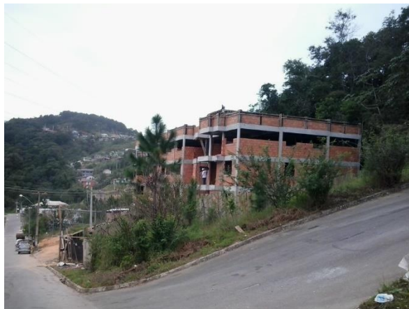
Figura 43 - Vista do Residencial em Construção em 2013
