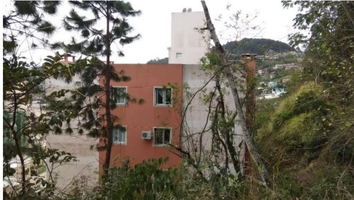
Figura 12 - Vista do apartamento 302 a partir do talude
