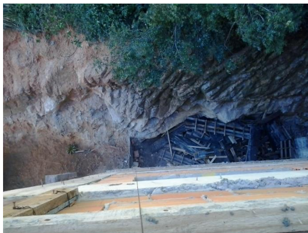
Figura 45 - Vista entre os fundos do residencial e o talude a partir do terceiro piso
