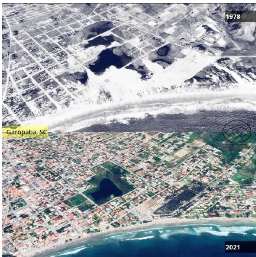
FIGURA 2: Processo de urbanização em torno da Lagoa das Capivaras. Acima, imagem de 1978 e abaixo de 2021. Fonte/Imagem: Quoos, João Henrique. Mosaico de fotografias aéreas de 1978 para Google Earth, 26/03/2021.
