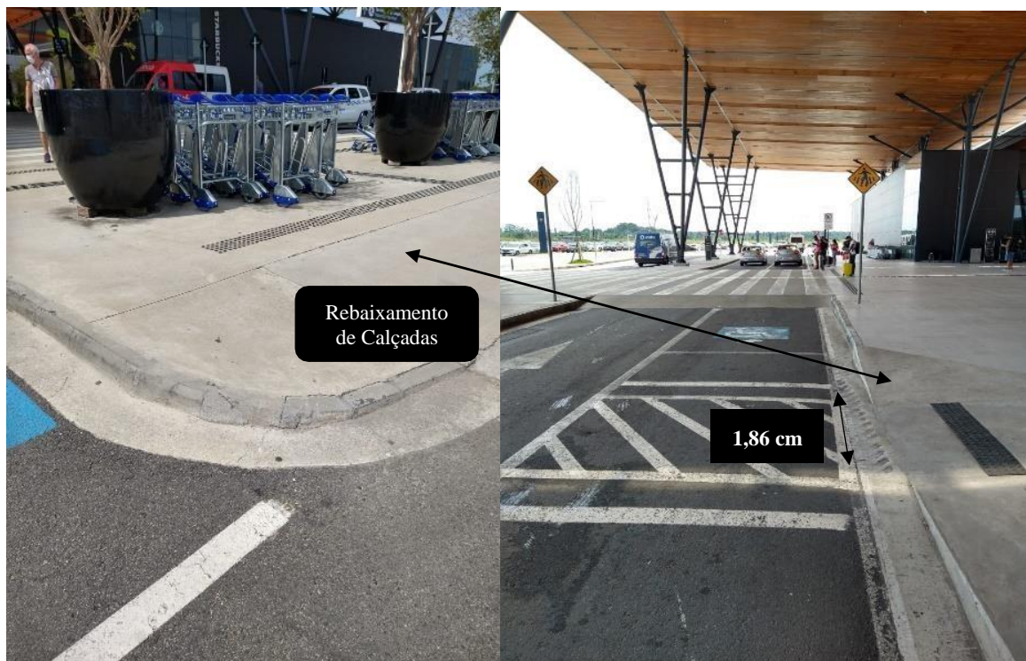
Figura 9 – Rebaixamento de Calçada no Acesso ao Boulevard 14/32.
