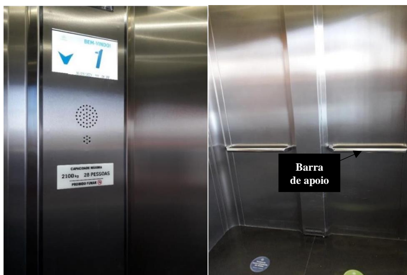
Figura 20 - Parte Interna do Elevador
