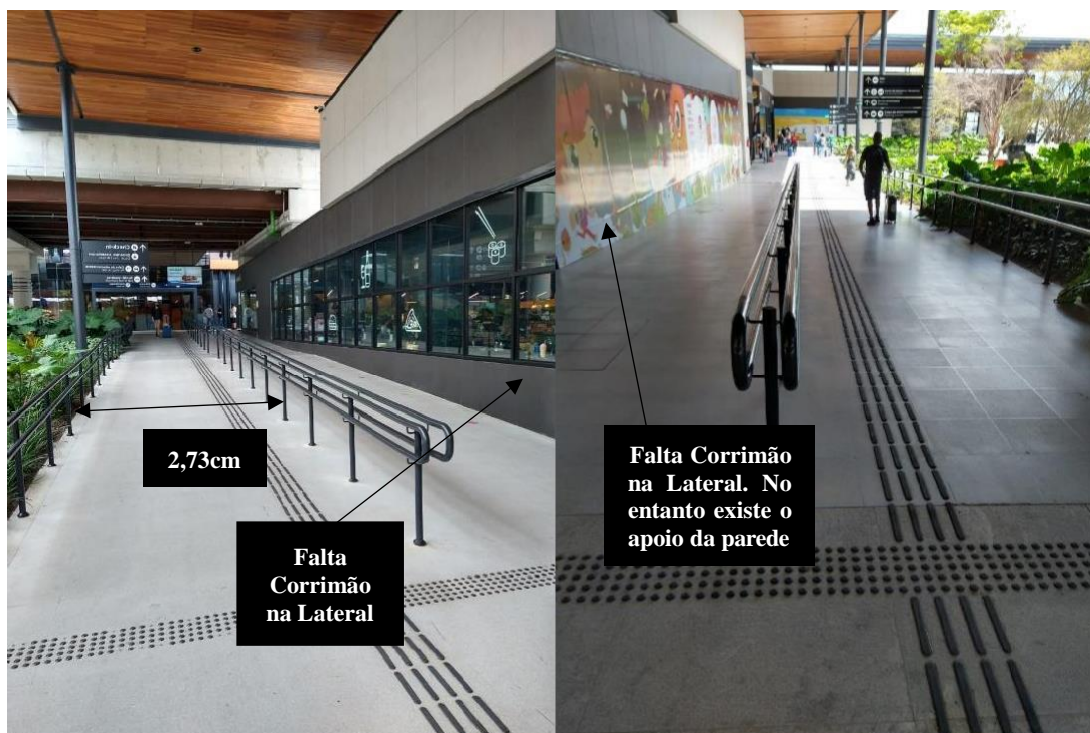
Figura 15 - Rampas de Acesso ao Terminal de Passageiros.
