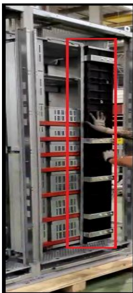
Figura 4: Duto de barras montado.
