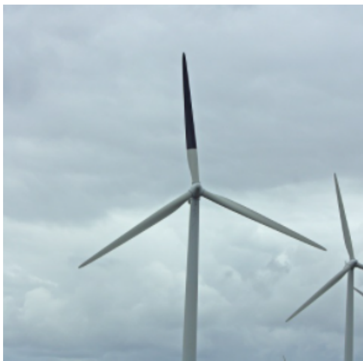
Figura 17 – Redução na taxa de mortalidade de aves em 72 % devido a pintura de uma das pás
