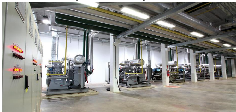
Figura 2 - Sistema de compressores.
