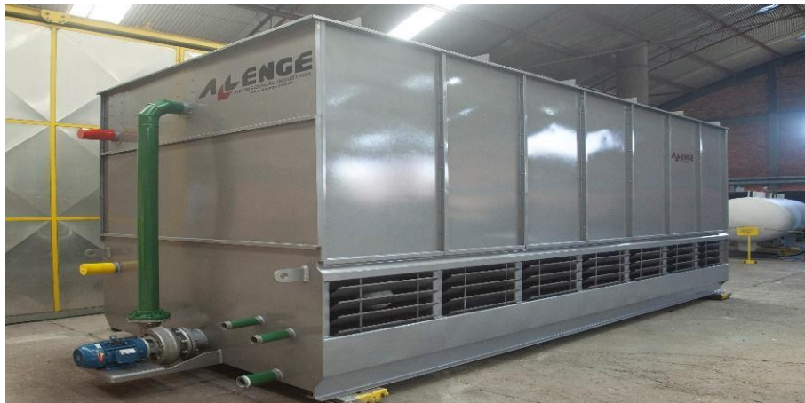
Figura 3 - Condensador evaporativo.
