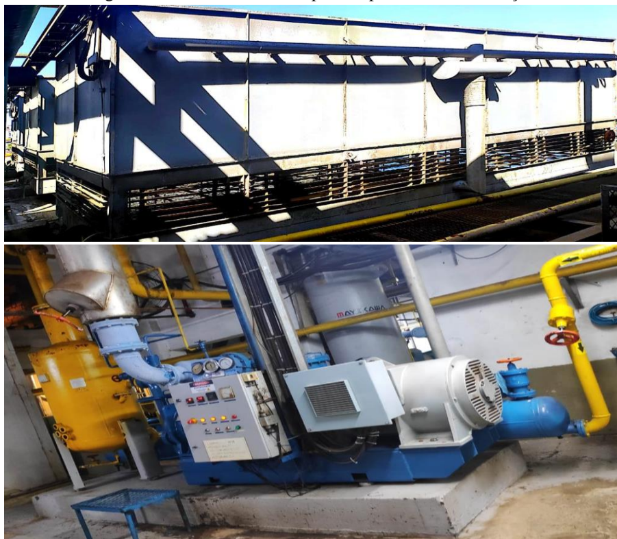
Figura 9 - Condensador e compressor presentes na instalação.
