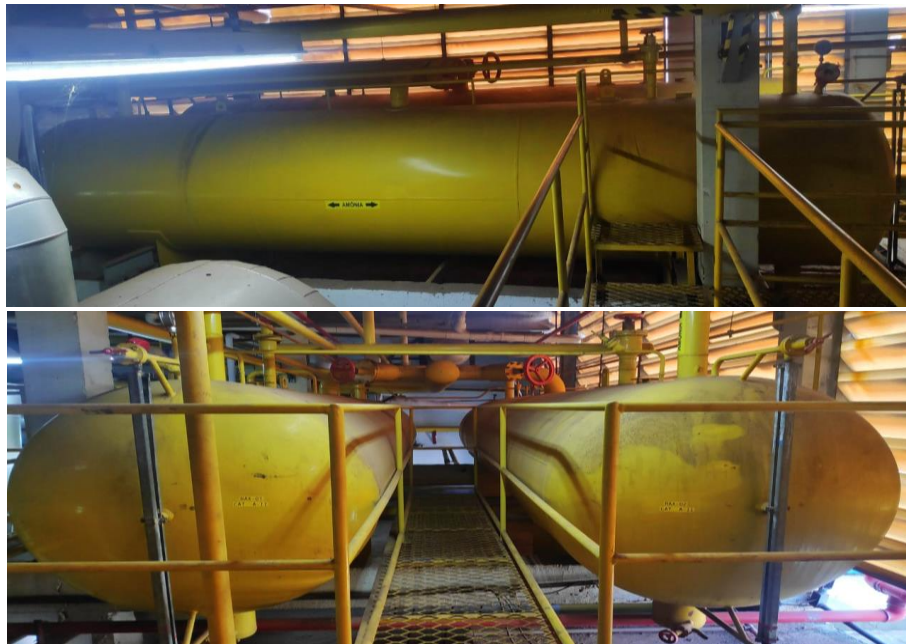
Figura 11 - Reservatórios de amônia líquida.
