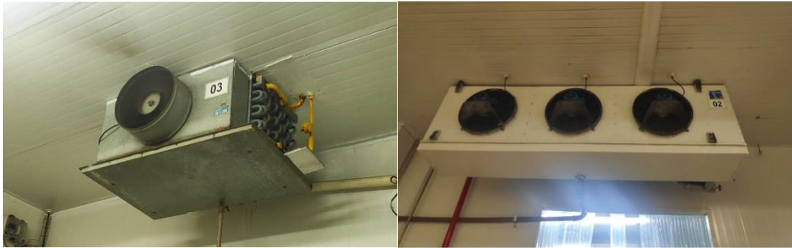
Figura 10 – Dois dos evaporadores responsáveis pela climatização dos ambientes.
