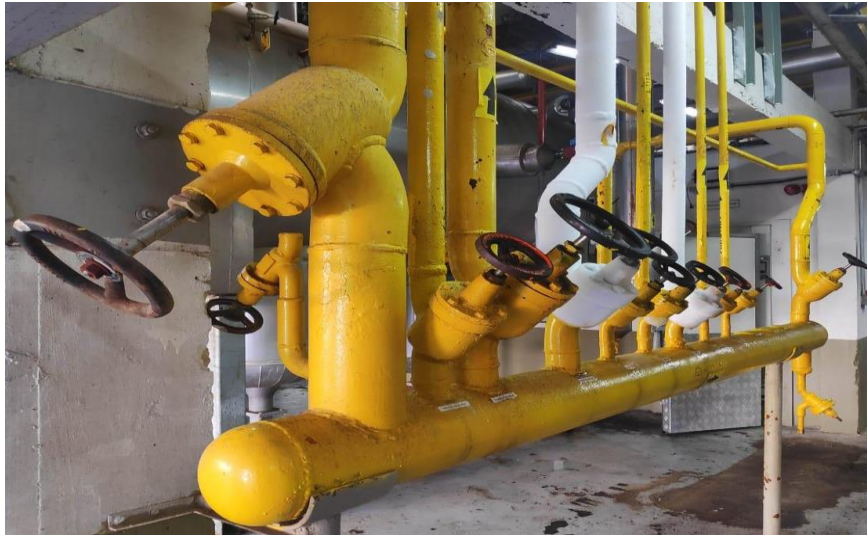
Figura 12 - Coletor/distribuidor de amônia.
