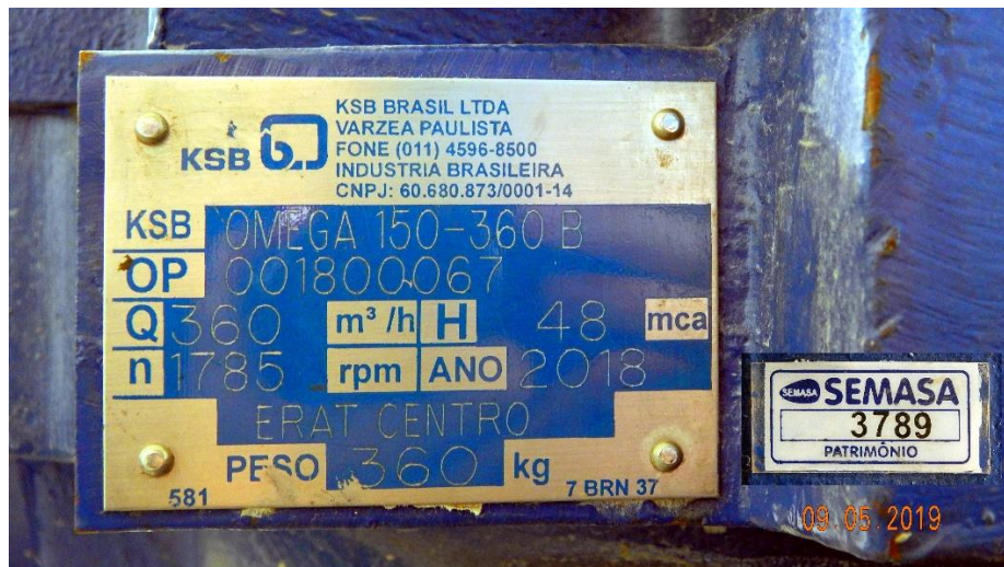
Figura 33 – Placa de informações da bomba do CMB 2
