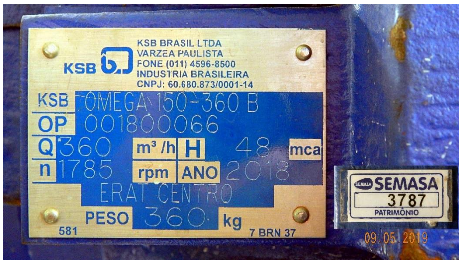
Figura 36 – Placa de informações da bomba do CMB 3
