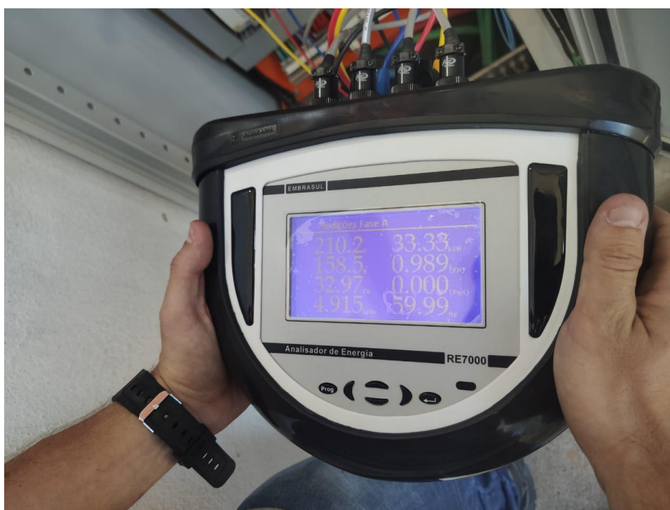
Figura 41 – Analisador de energia RE7000 em funcionamento
