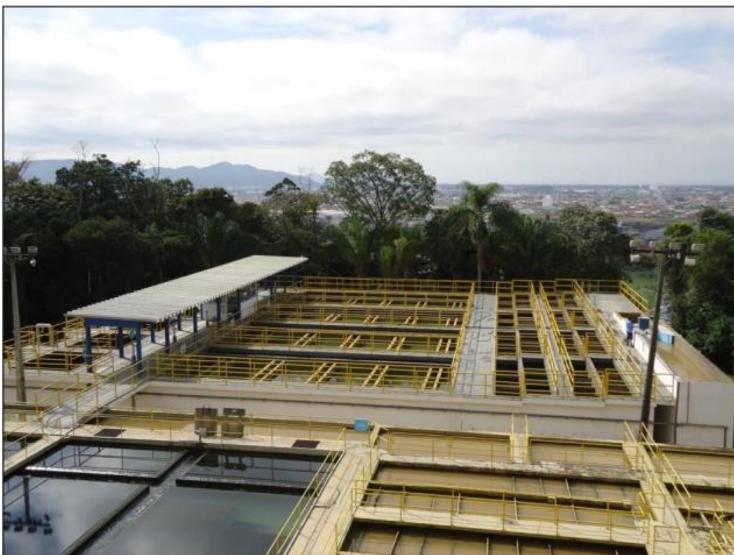
Figura 23 – Estação de Tratamento de Água do São Roque
