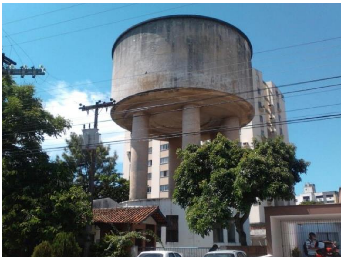
Figura 27 – Reservatório desativado na ERAT Centro
