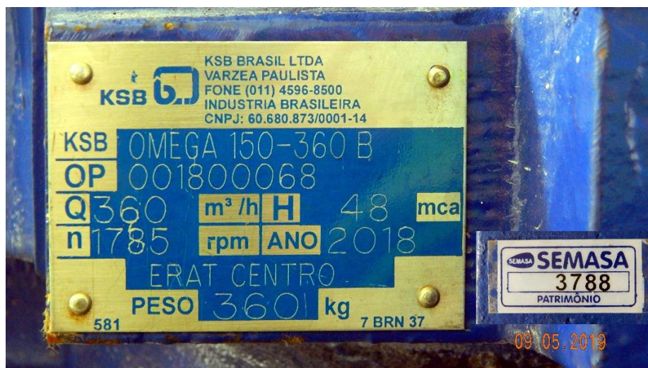
Figura 30 – Placa de informações da bomba do CMB 1
