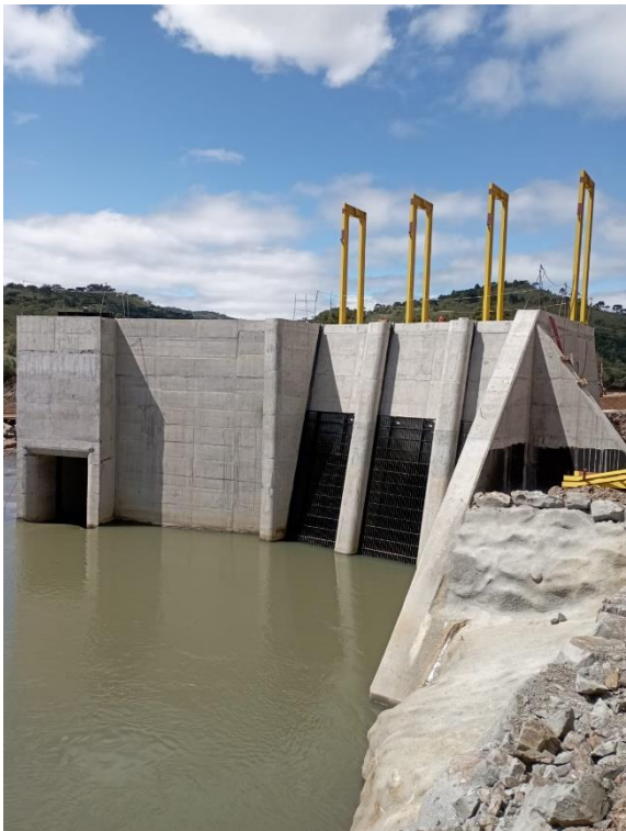
Figura 12 - Montagem do pórtico
