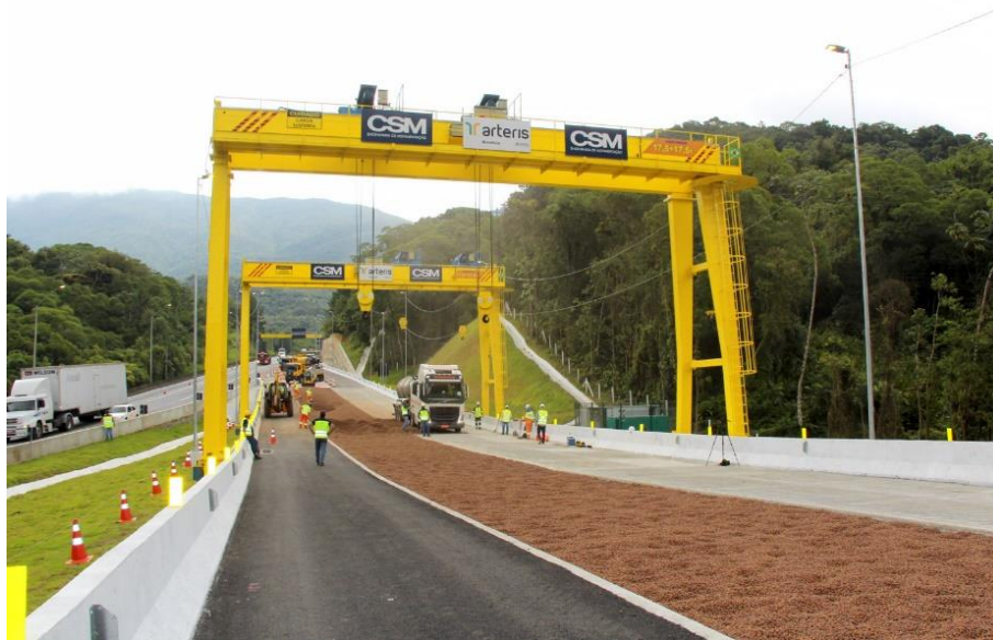
Figura 6 – Pórticos dupla viga da área de escape na BR-153
