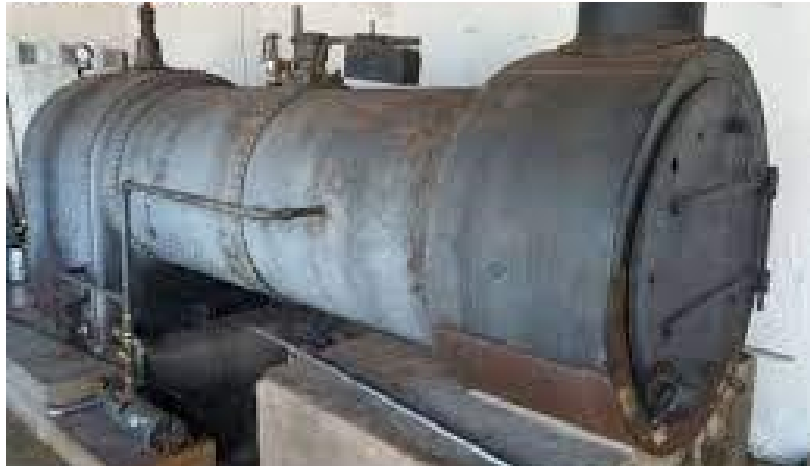
Figura 7 - Caldeira flamotubular horizontal.
