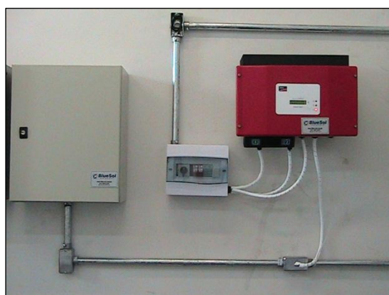
Figura 9 - Exemplo de encaminhamento de cabos até painéis
