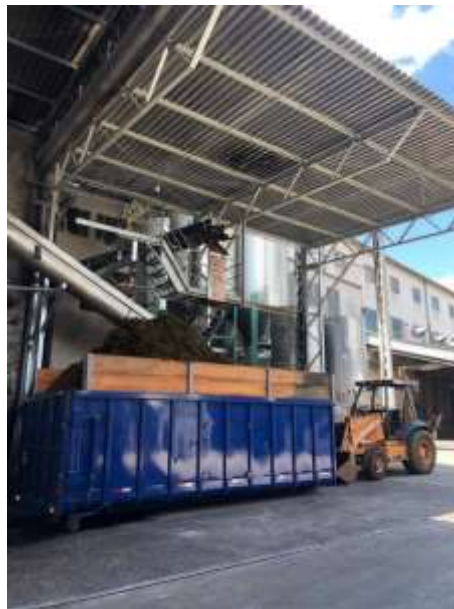
Figura 9: Container de recebimento dos engaços
