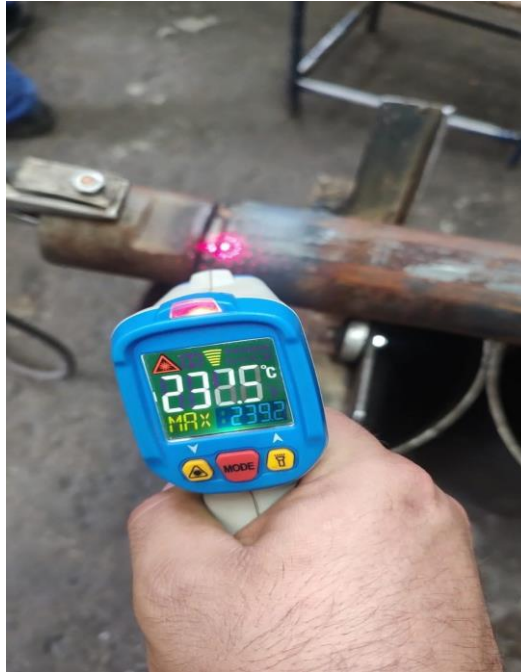
Figura 14 - Temperatura de pré-aquecimento no chanfro
