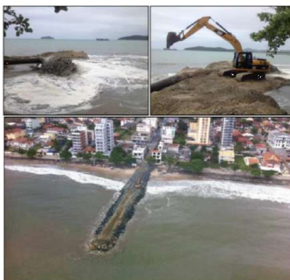
Figura 8 – Construção do aterro hidráulico realizado na Praia Central de Balneário Piçarras no ano de 2012
