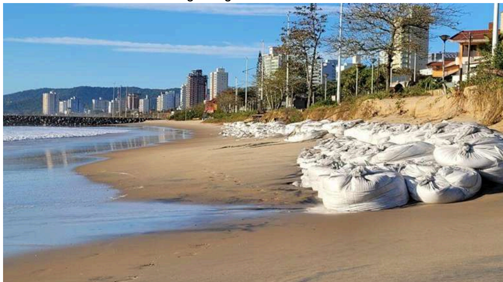
Figura 7 – Estruturas denominadas "geobags" colocadas na Praia Central de Balneário Piçarras
