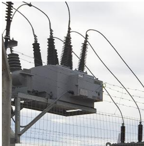
Figura 2 - Religador tripolar 36kV
