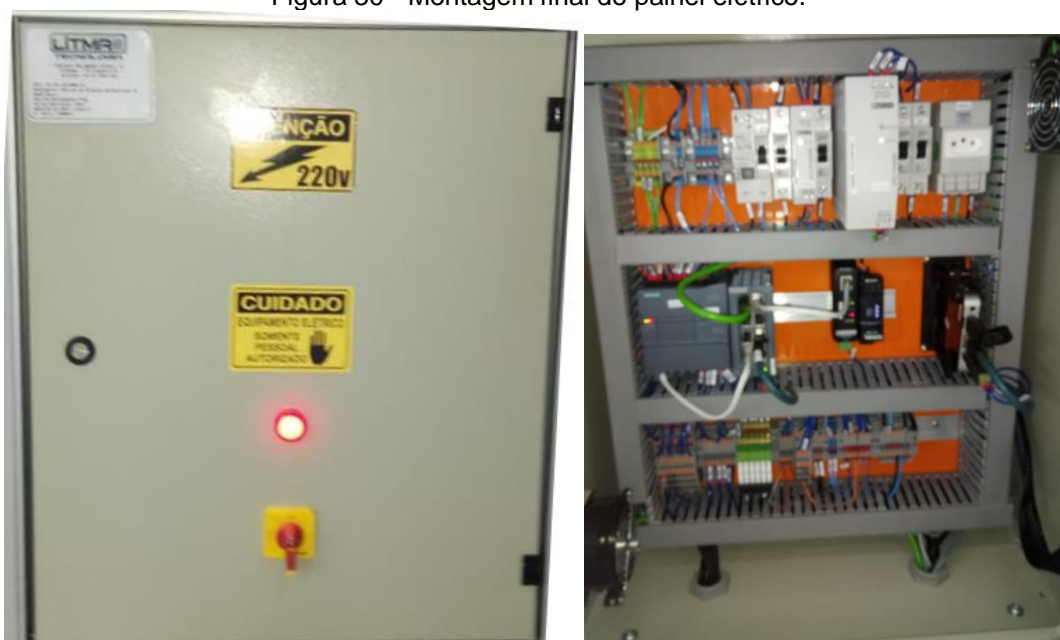
Figura 30 - Montagem final do painel elétrico.
