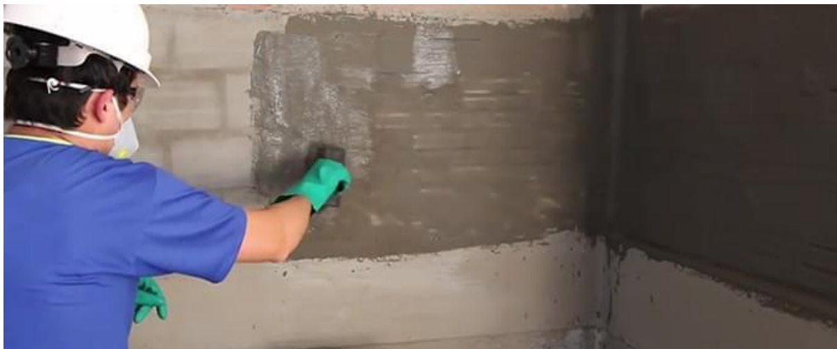
Figura 11 – Impermeabilização de paredes enterradas.
