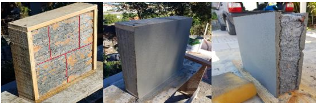
Figura 16 – Execução de parede de alvenaria, com destaque nas juntas de amarração.
