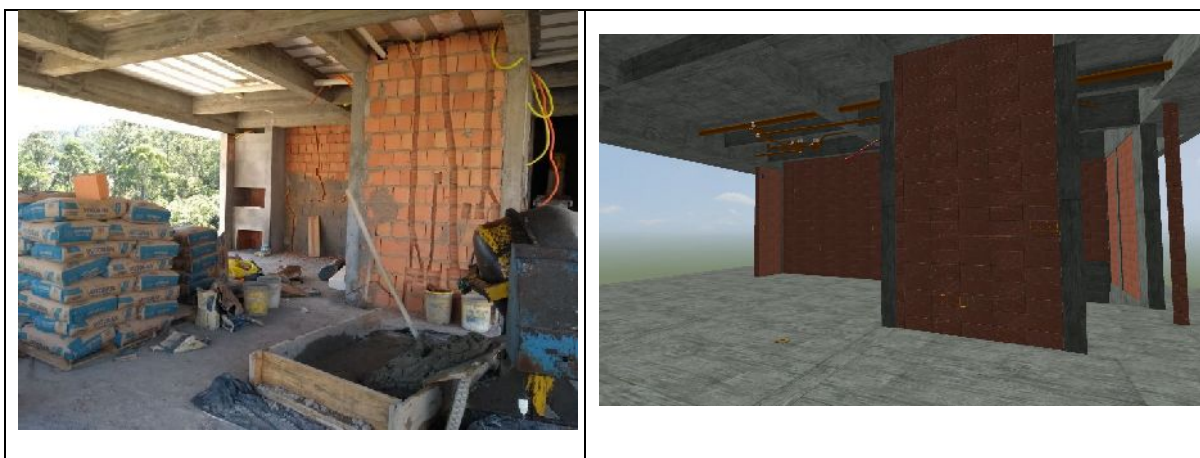
Figura 22 - Real x Modelo BIM - Visita 1
