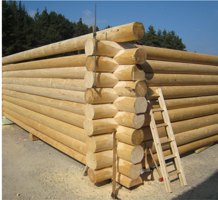
Figura 6: Sistema Construtivo com Toras Empilhadas
