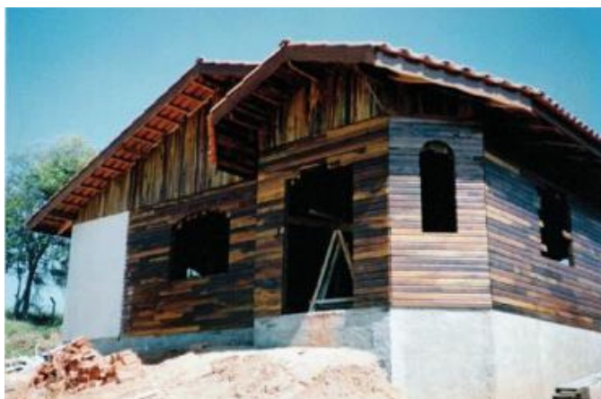
Figura 3: Casa sendo construída no Sistema de tabuas horizontais pregadas.
