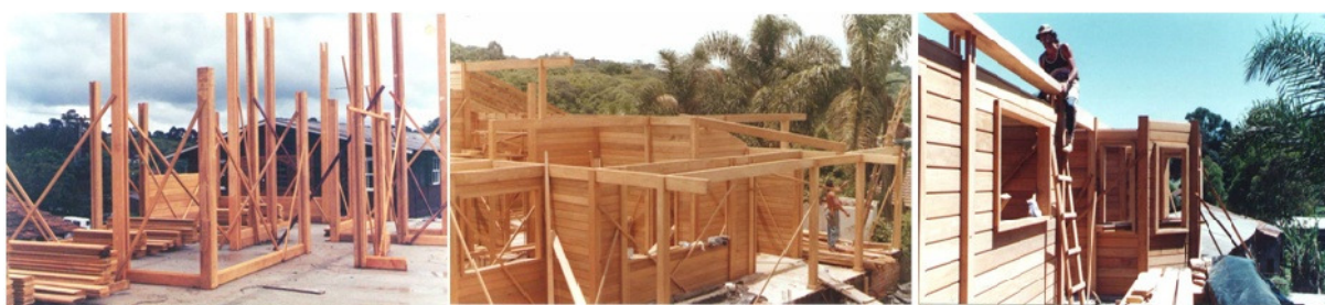
Figura 5: Esquema construtivo de uma casa de "Encaixe"
