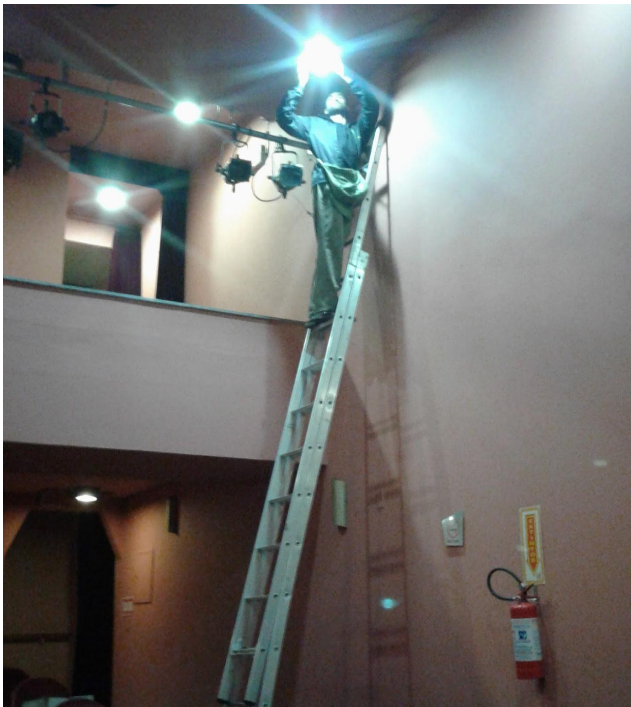
Figura 9 – Troca da iluminação fluorescente por lâmpadas de Led
